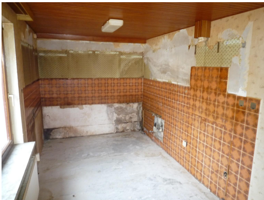
Küche im Anbau
