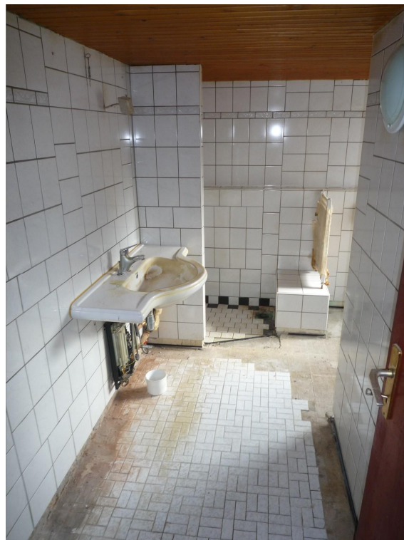
"Bad" im Anbau
