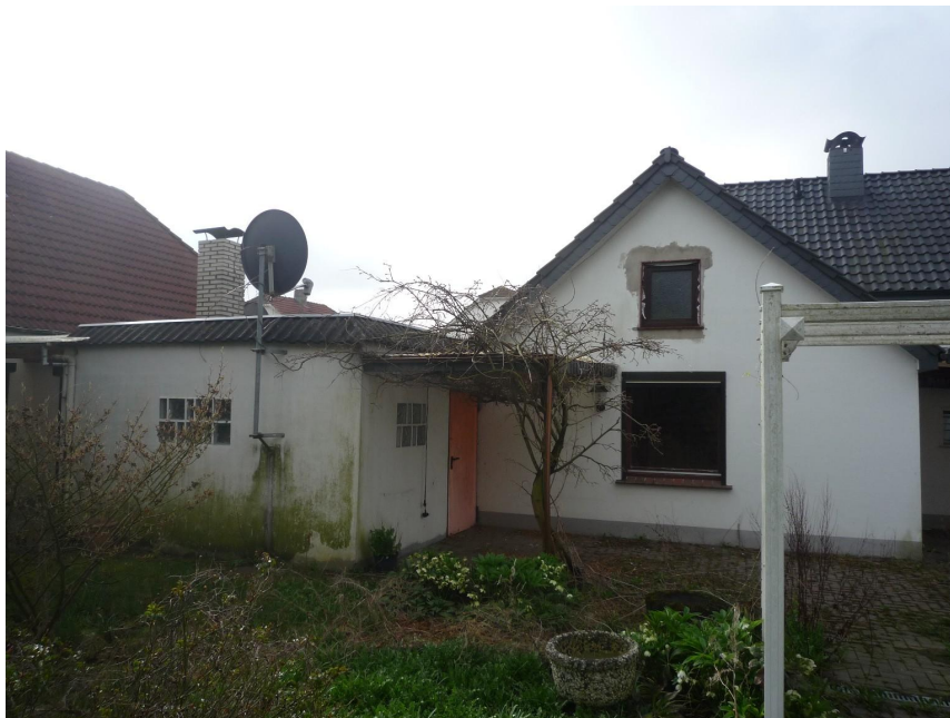
rückwärtiger Blick auf die Garage
